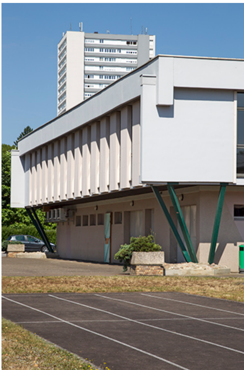
Pignon sud de la cantine.
