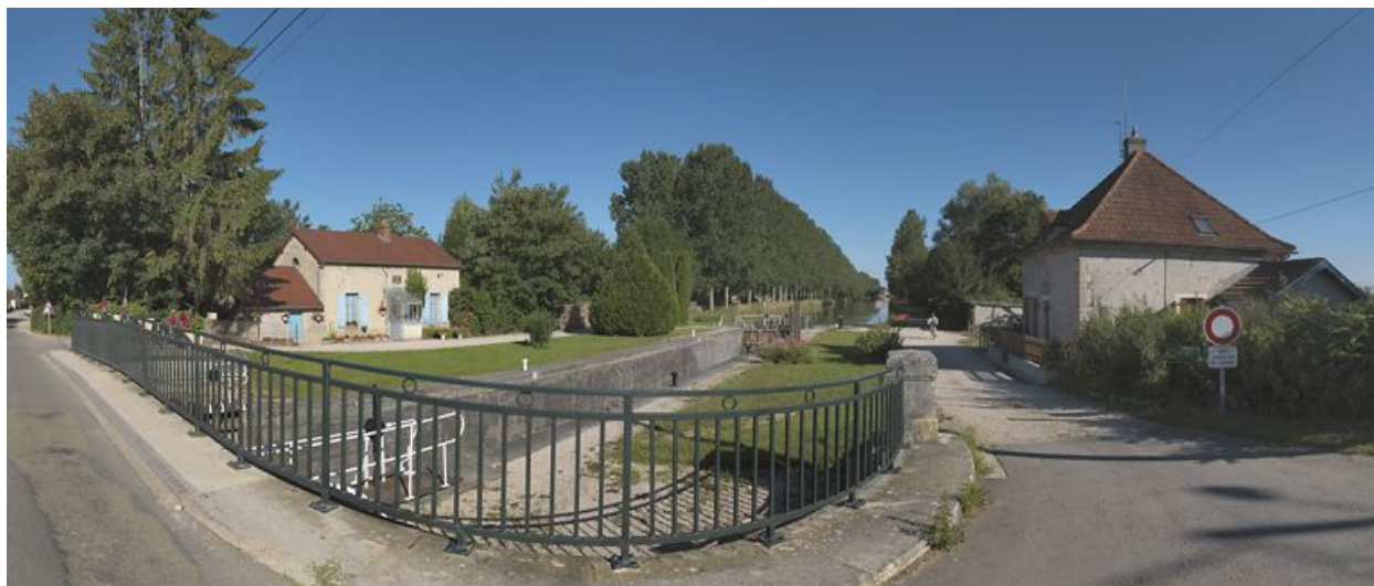
Vue d'ensemble du site, prise d'aval.
