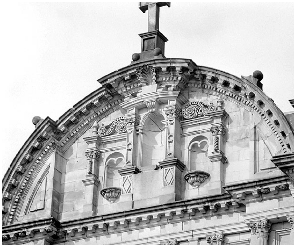
Façade principale, fronton.
