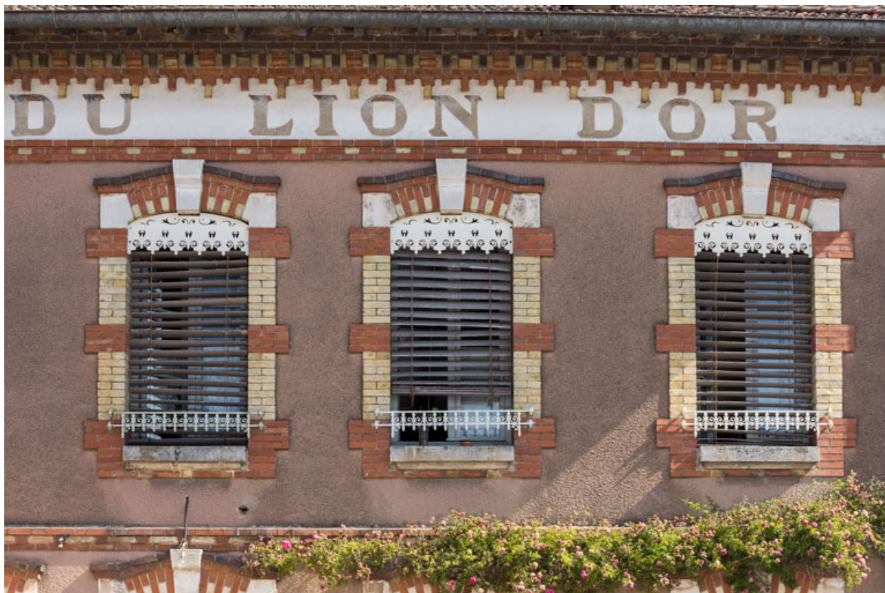
Hôtel-restaurant : façade postérieure, baies à l'étage.
