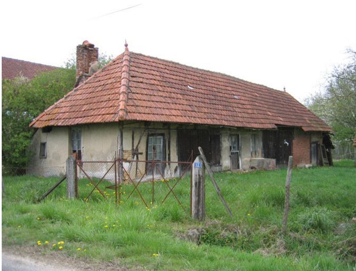
Vue d'ensemble de la façade.
