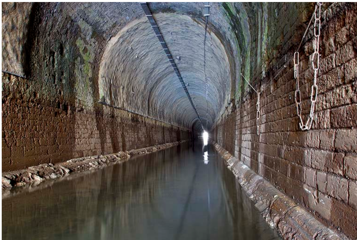
Intérieur du tunnel, vue générale.
