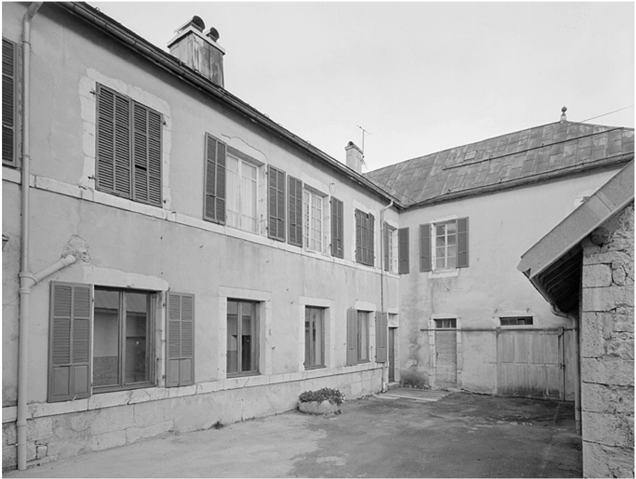
Cour intérieure : logis de la cure.
