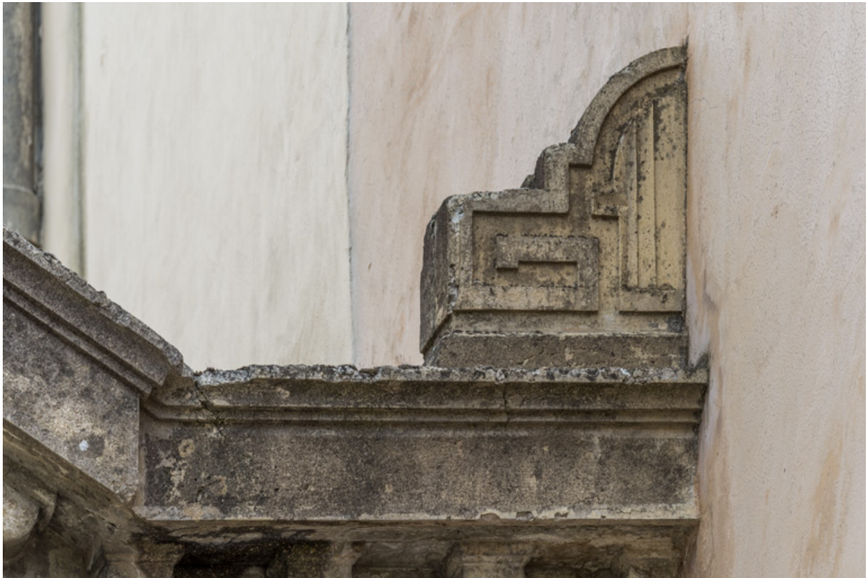
Façade antérieure : décor en partie supérieure.
