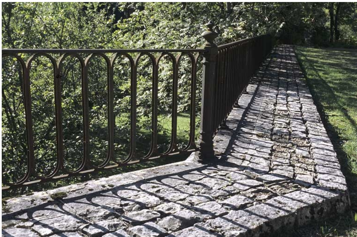
Garde-corps métallique de la cour des voyageurs.
