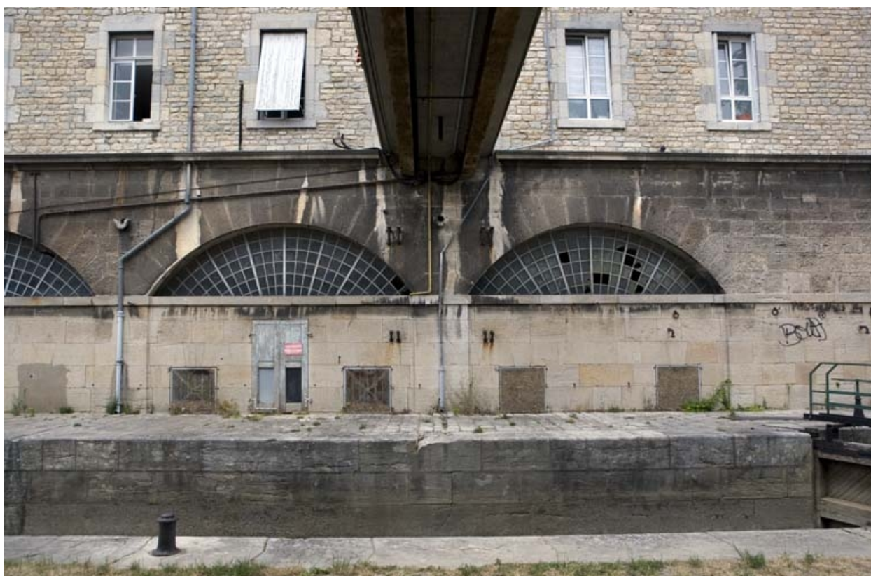
Baies des casemates, à l'étage de soubassement.
