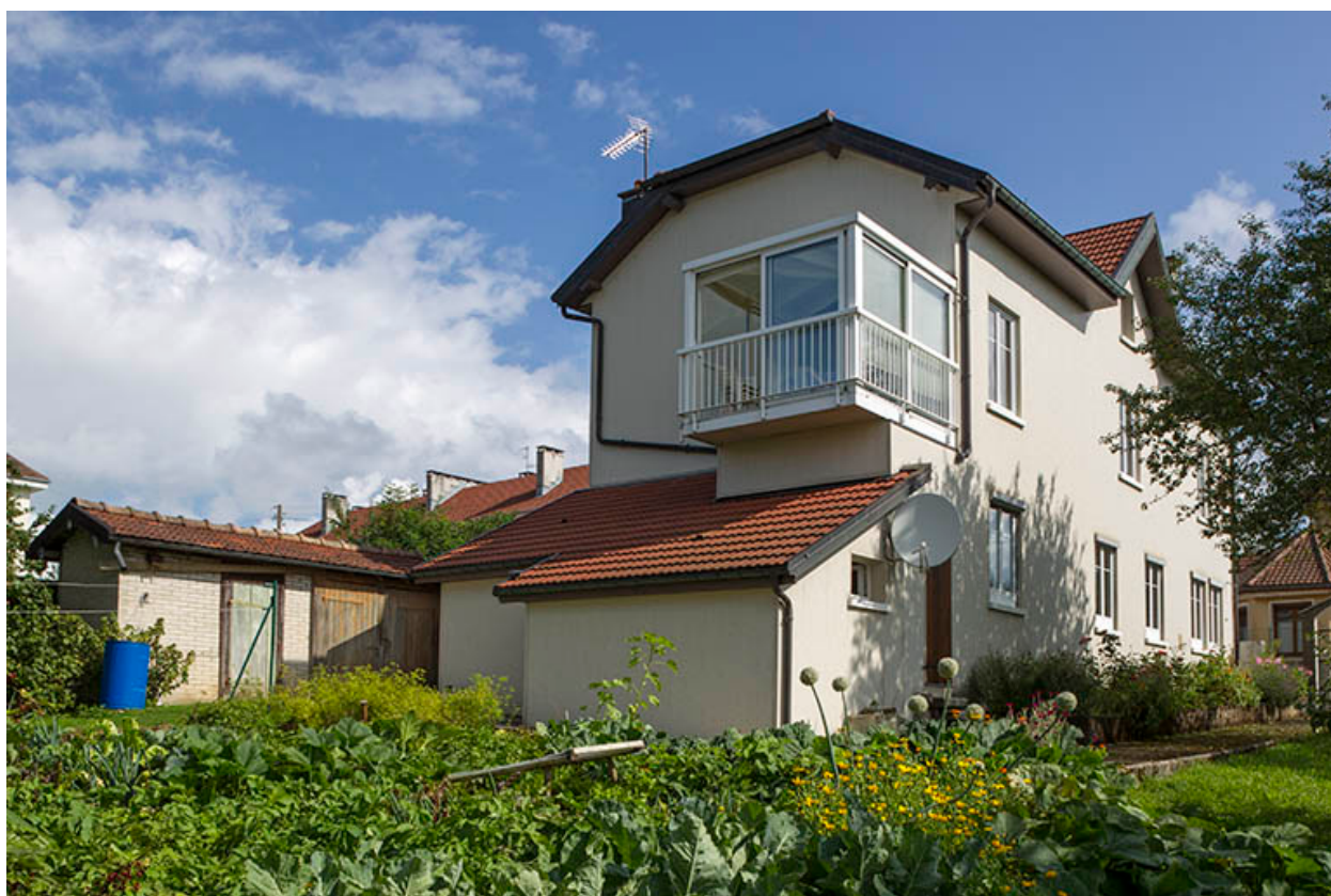
Façades postérieure et latérale droite.
