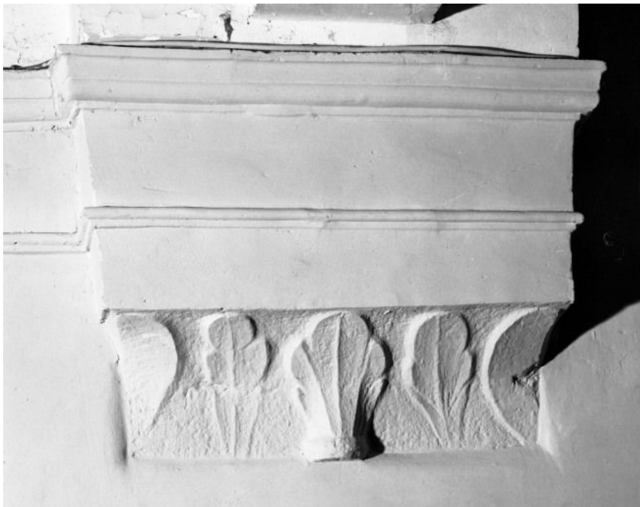
Nef, mur antérieur, pilastre gauche
