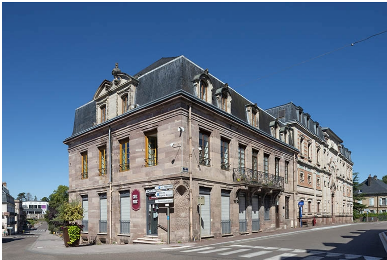
Maison Desgranges, façade sud et façade est.
