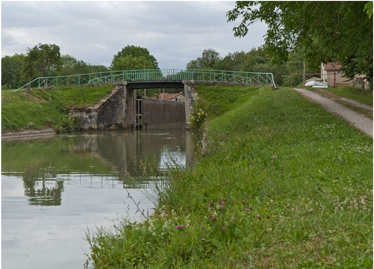
Vue du pont depuis l'aval.
