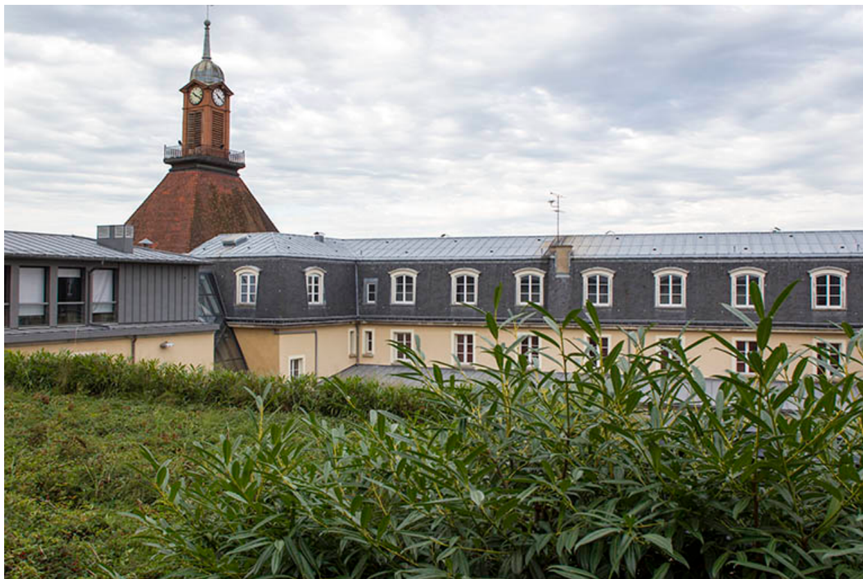
Toitures du quadrilatère des jacobins au 1er plan, la toiture végétalisée de l'aile Nord.
