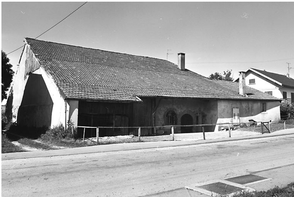
Gouttereau sur rue.
