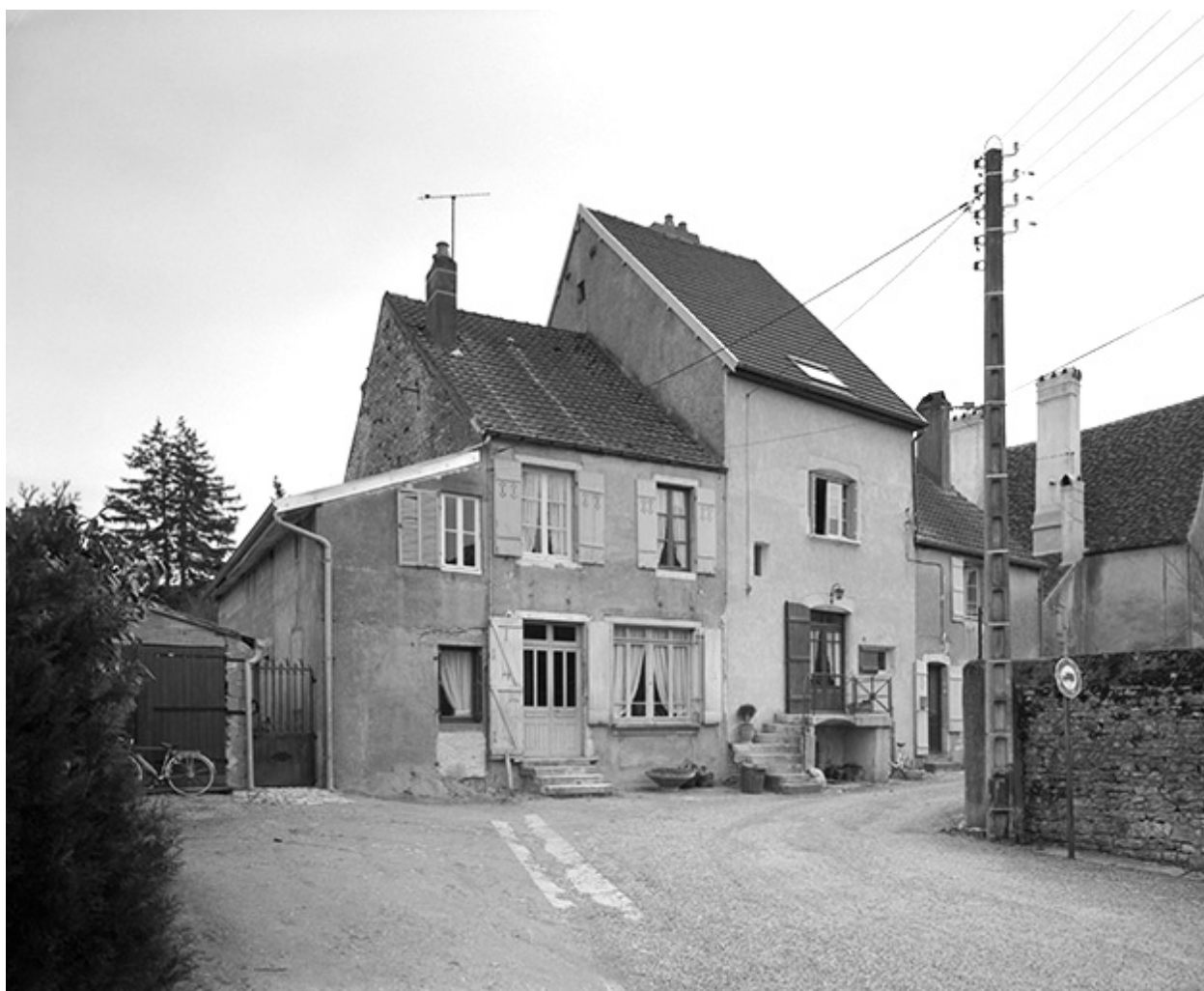
Maison située rue Sainte-Anne : vue d'ensemble.
