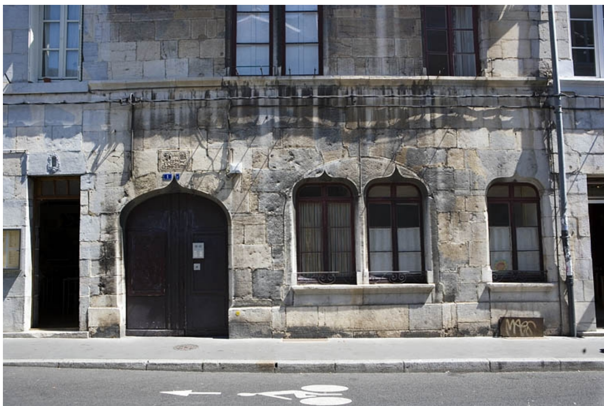
Détail du rez-de-chaussée sur rue.
