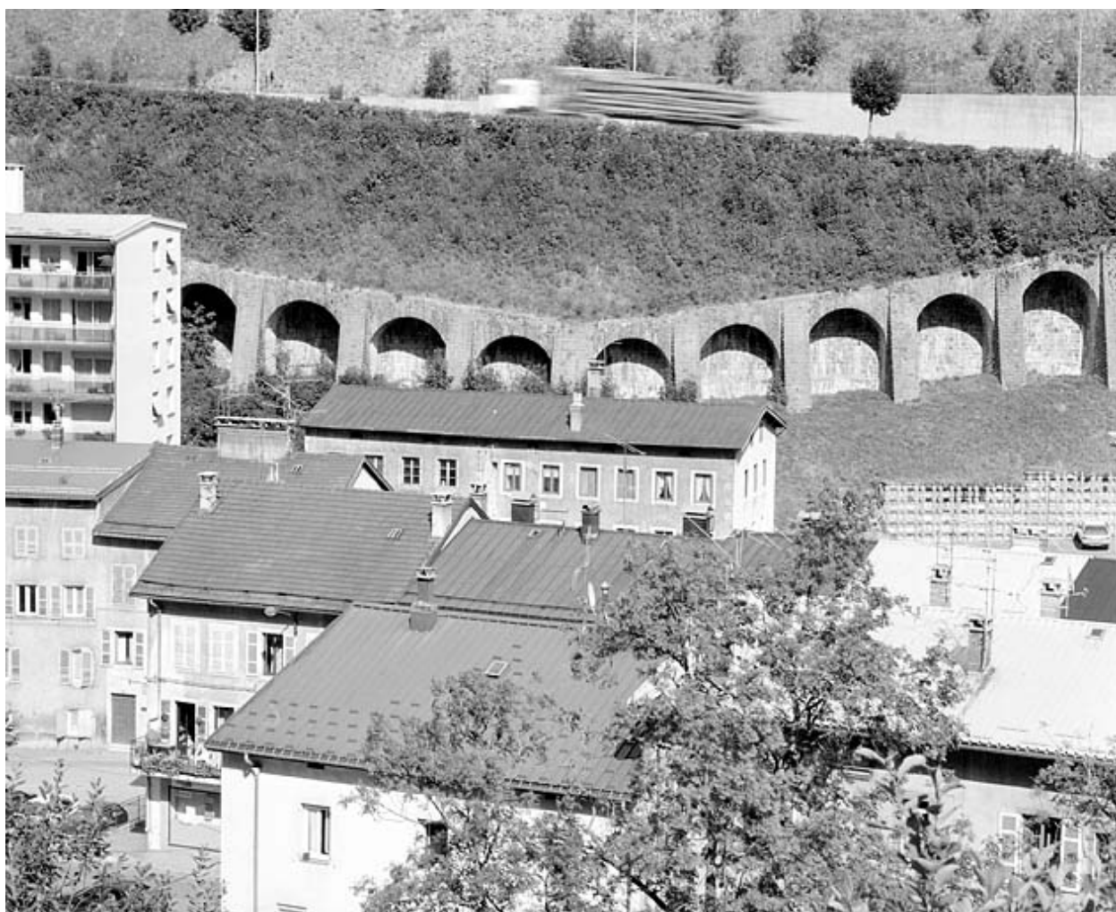
Mur à arcades, depuis l'ouest.
