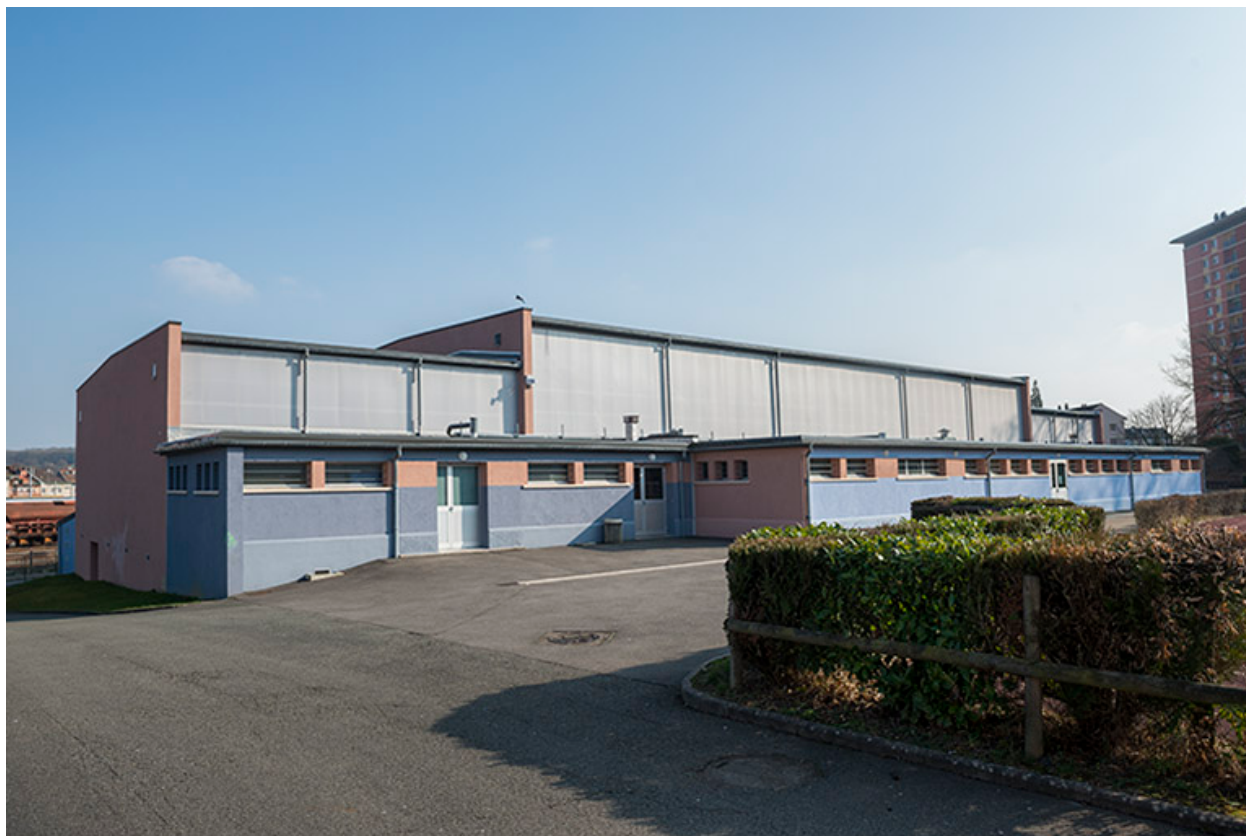
Angle nord-ouest du gymnase, façade antérieure.
