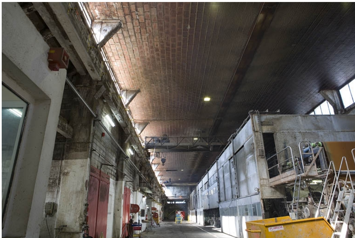
L'atelier de la machine à papier. Plancher supérieur en briques creuses suspendues.
