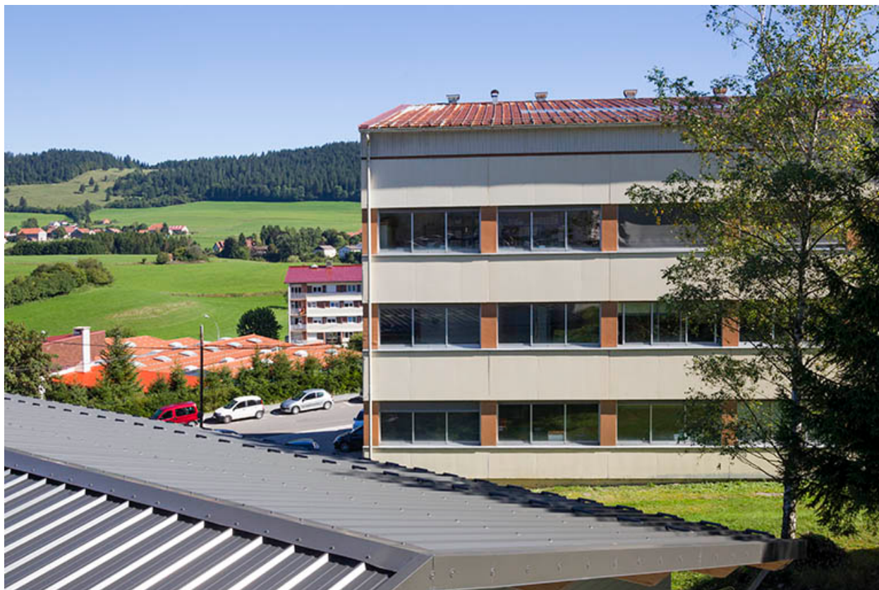
Corps nord : façade postérieure.
