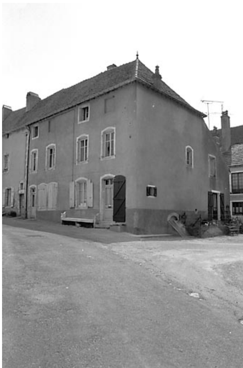
Maison située 7 rue Saint-Hilaire : vue d'ensemble.
