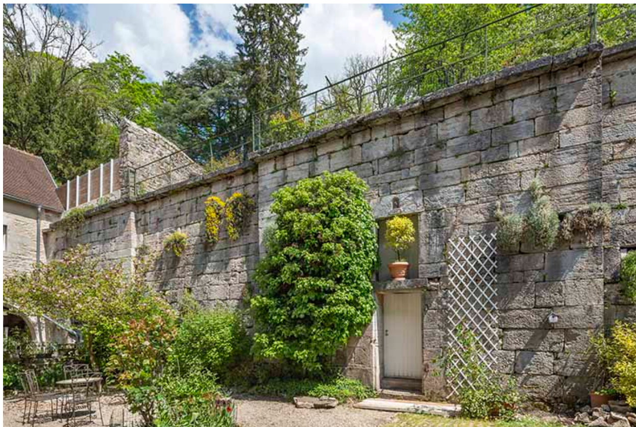
Mur de la terrasse en terre-plein.
