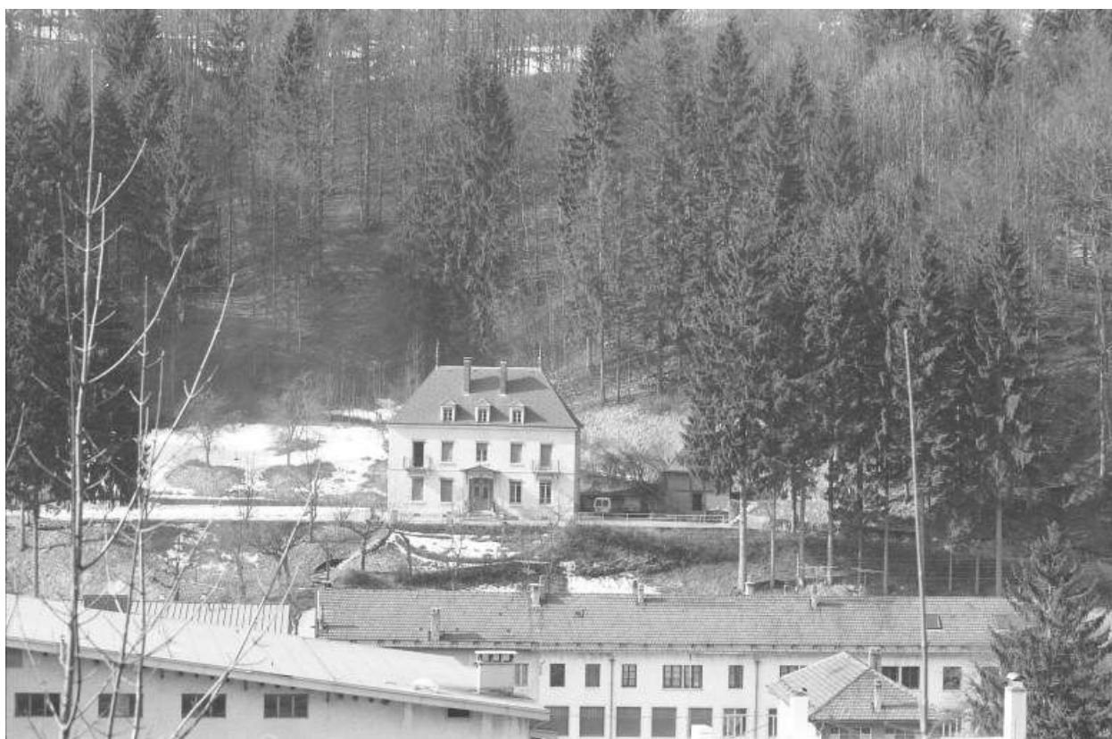
Vue d'ensemble du logement patronal.
