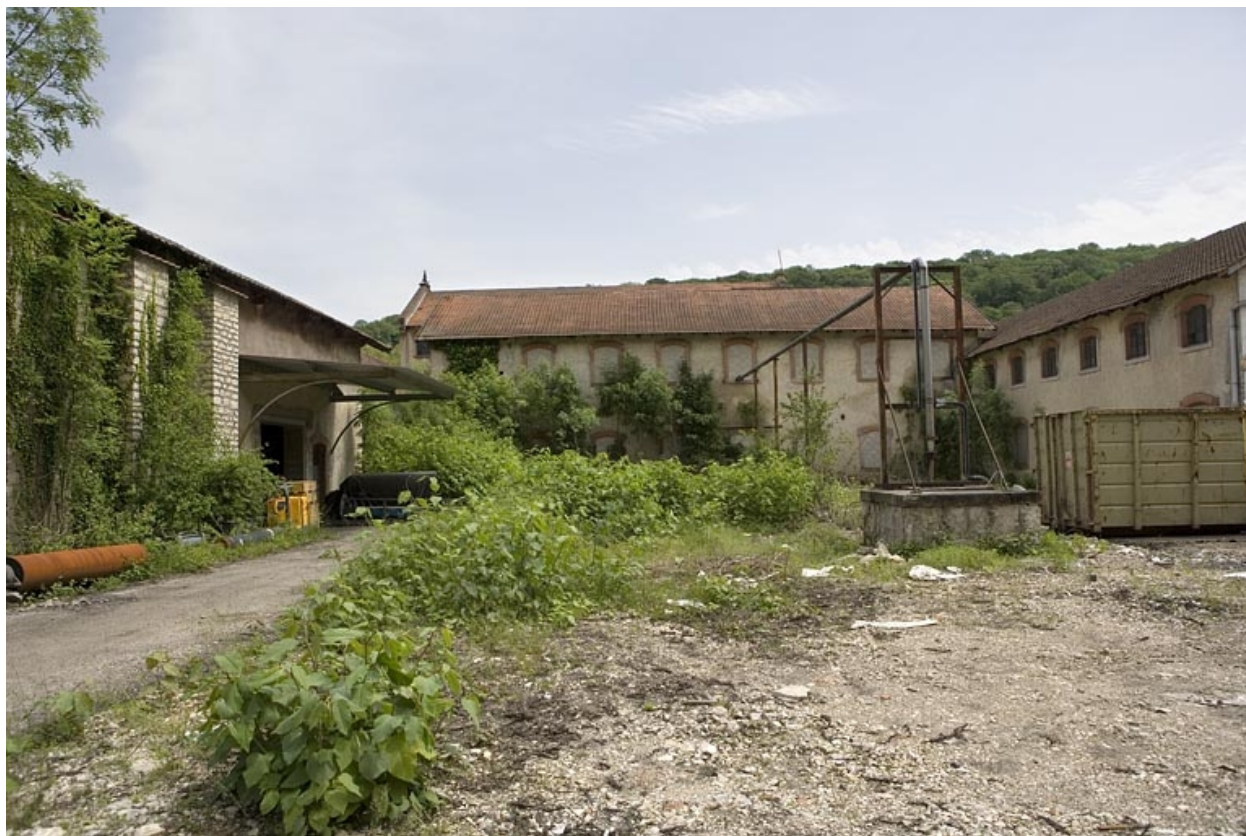
Entrepôt industriel (?). Façade ouest.
