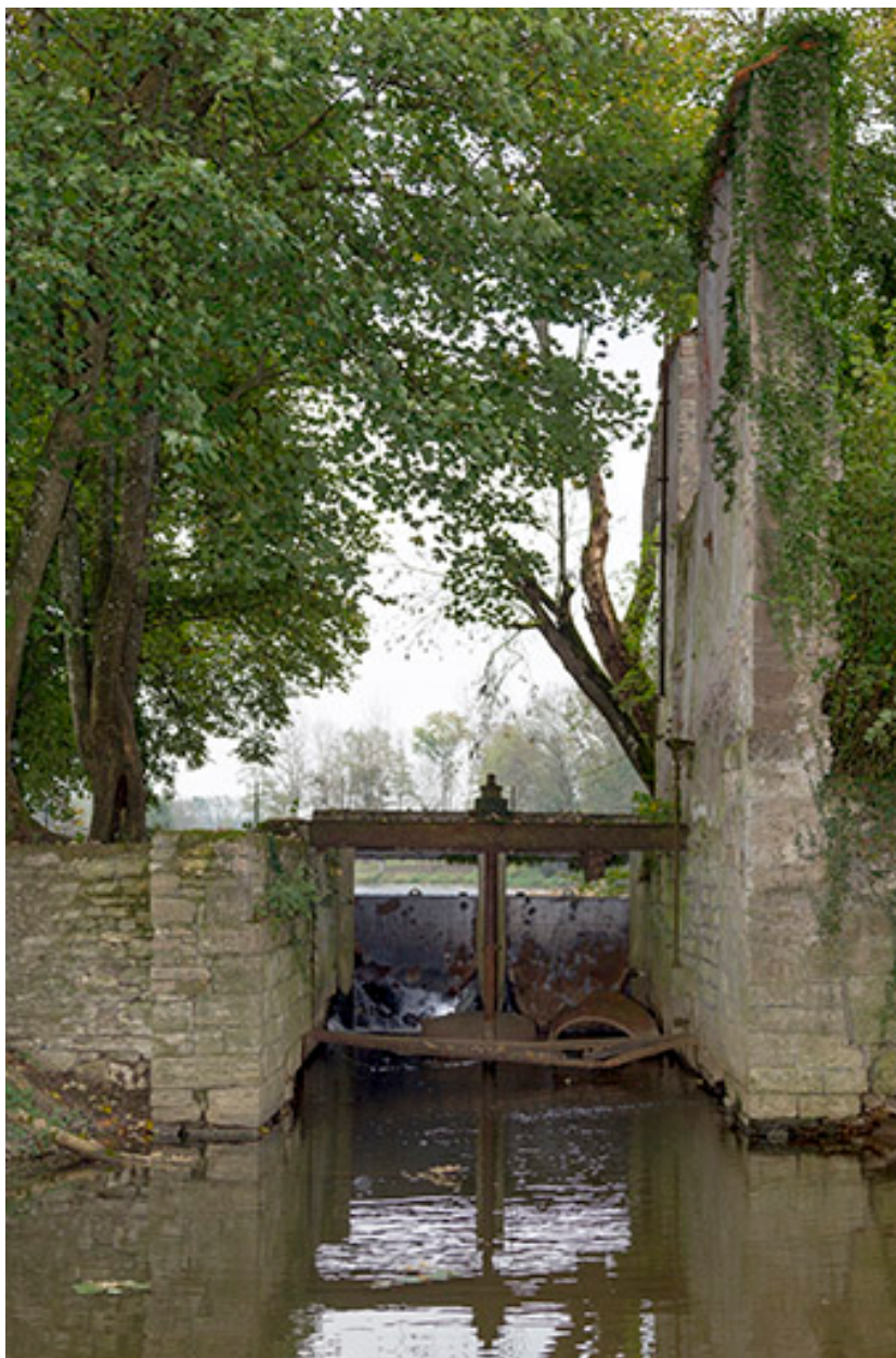
L'ancien canal de dérivation du moulin.
