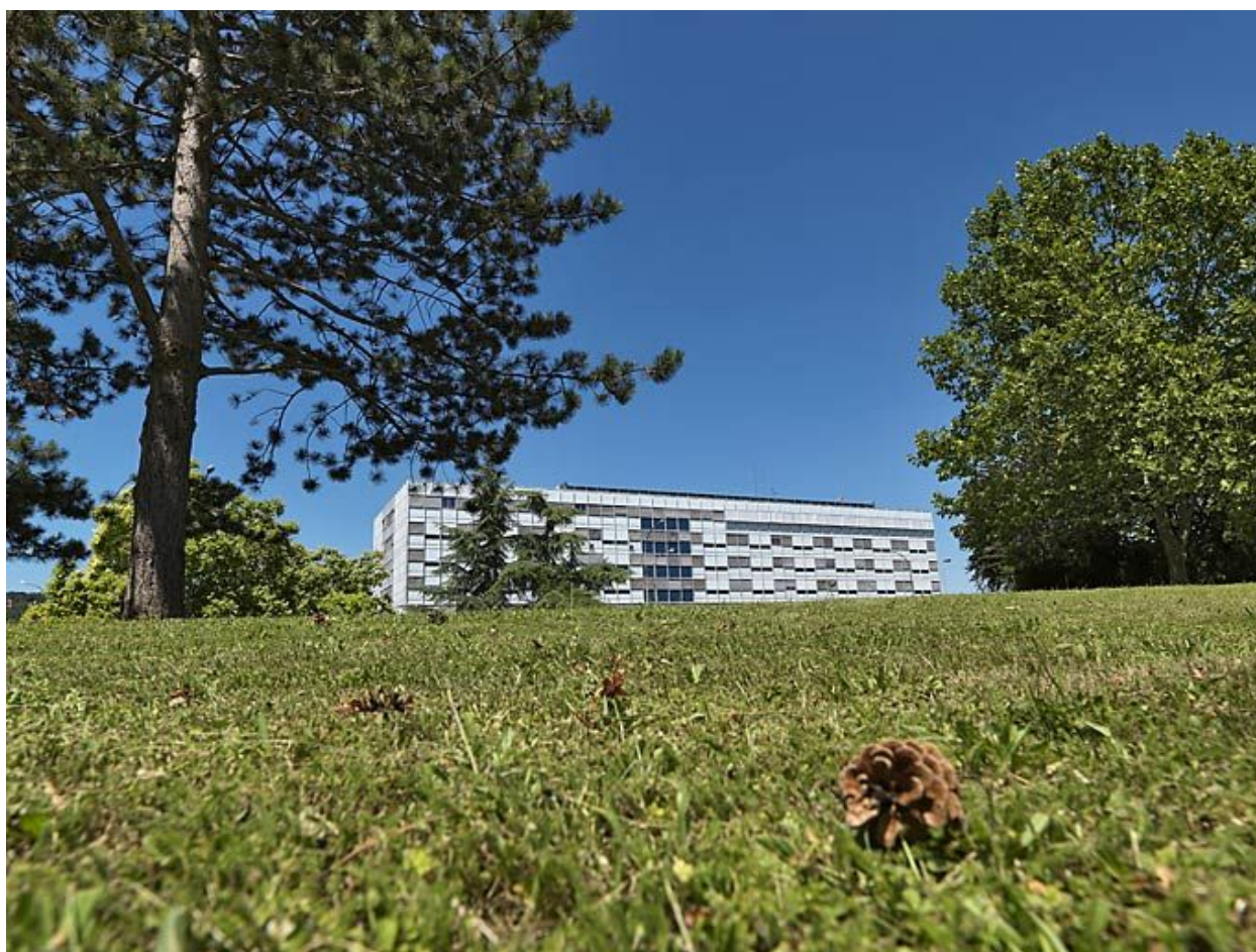
Bâtiment principal, vue d'ensemble.
