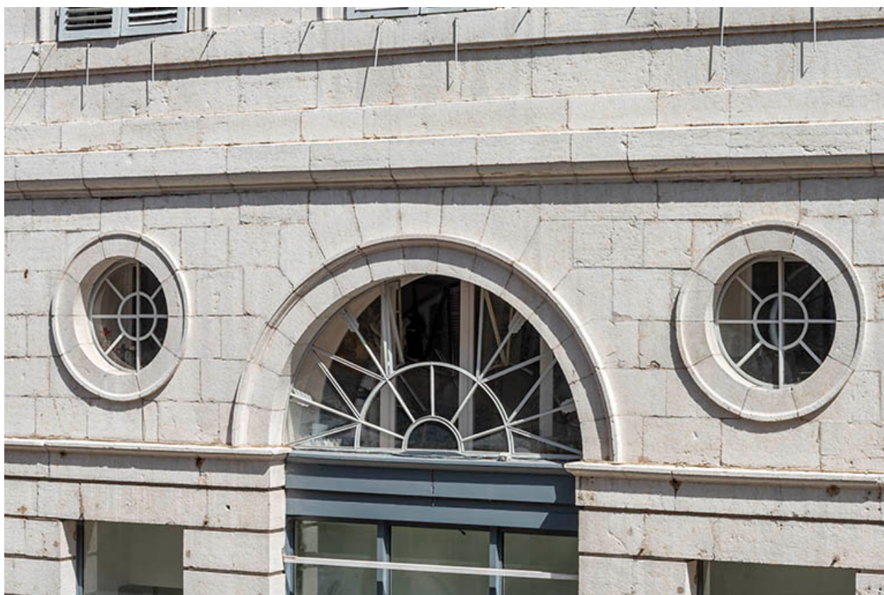
Façade antérieure. Ouvertures de l'entresol.
