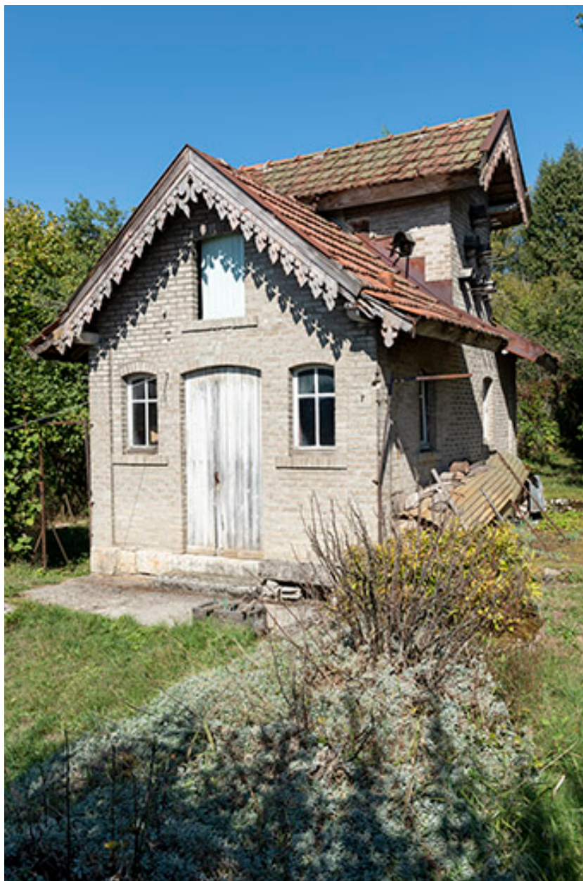
Pigeonnier : façade antérieure, de trois quarts droite.
