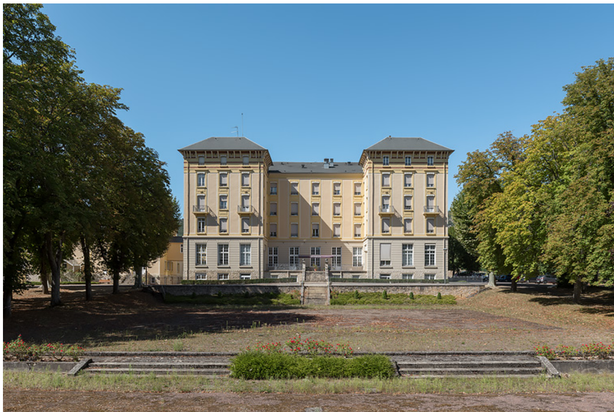
Façade principale sur le parc.
