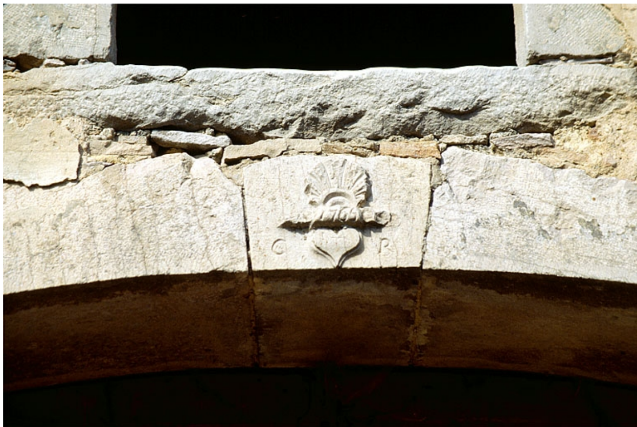
Bâtiment du bureau : clé de voûte sculptée.
