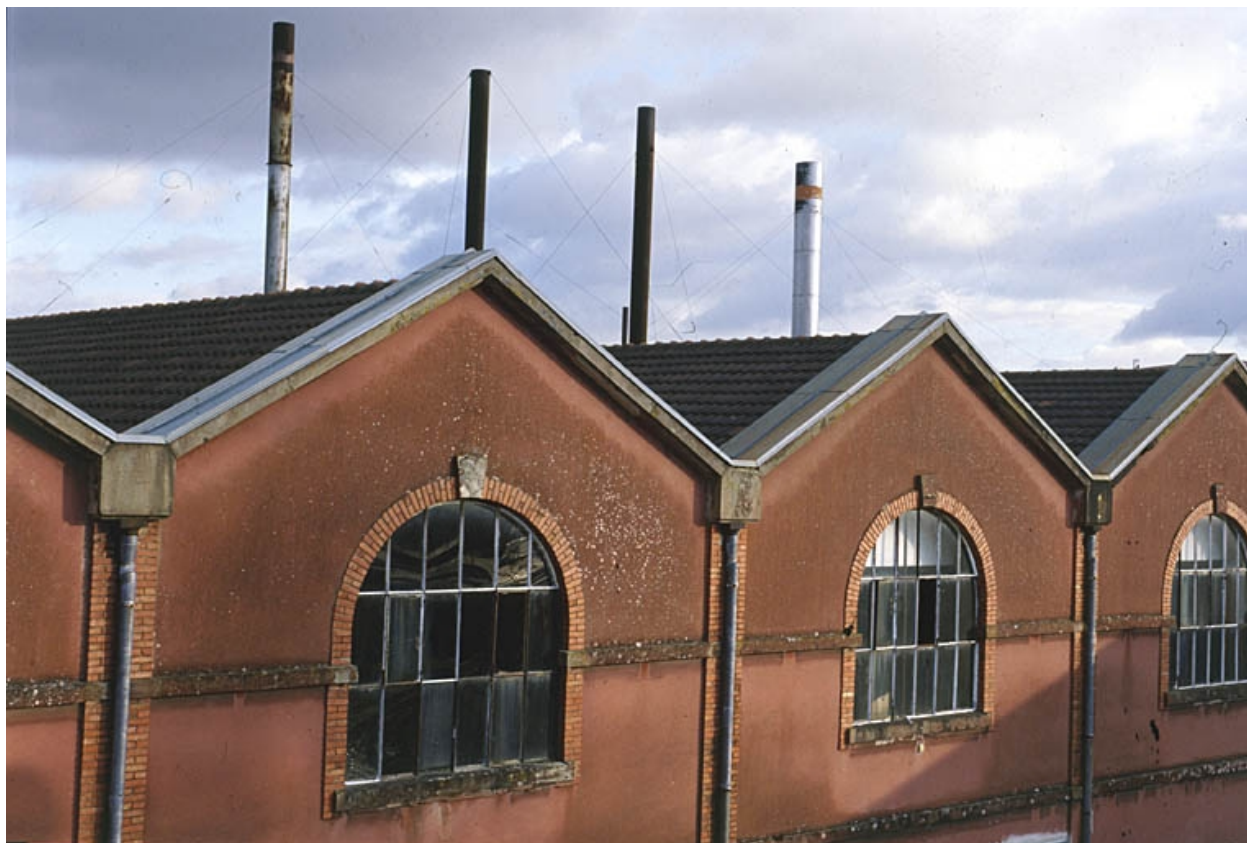
Chaufferie : façade ouest.
