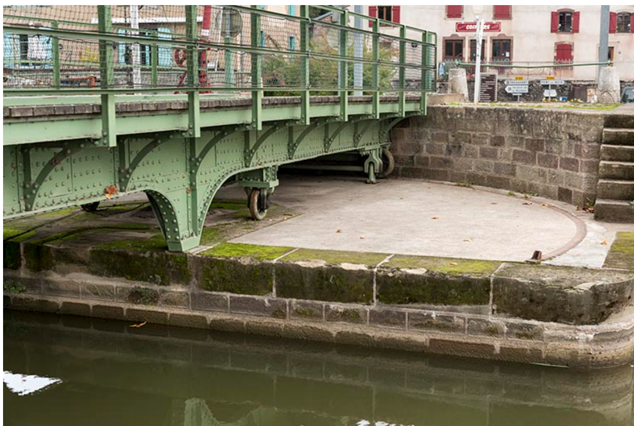
Détail de la plateforme maçonnée.
