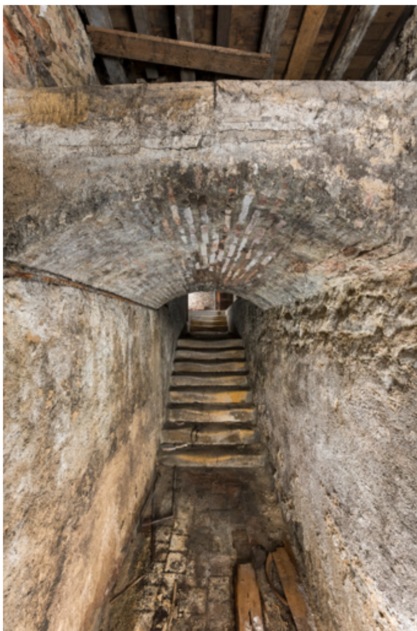
Couloir et escalier sous la salle.
