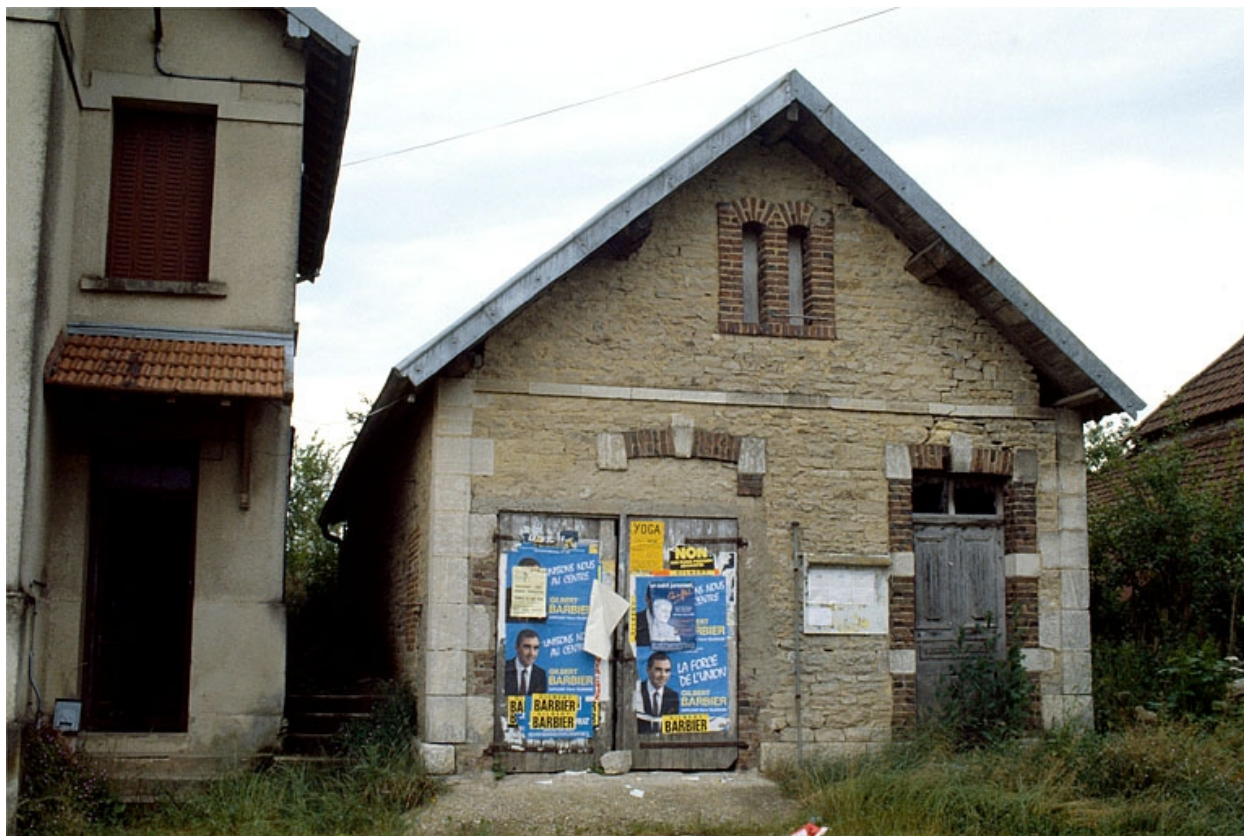
Remise vue de face.
