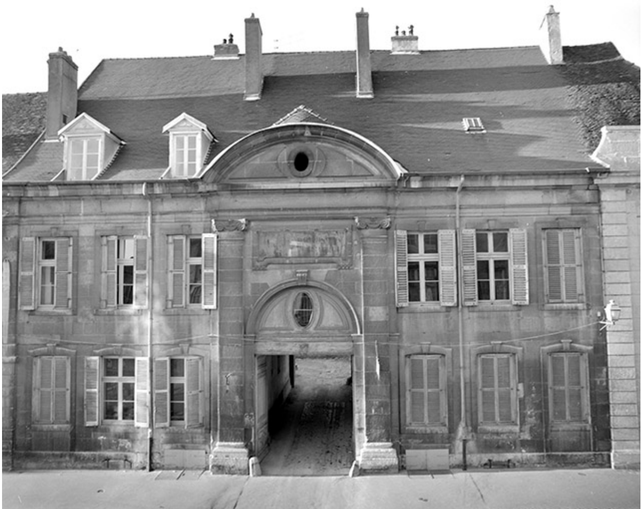
Façade antérieure de l'hôtel, vue de face.
