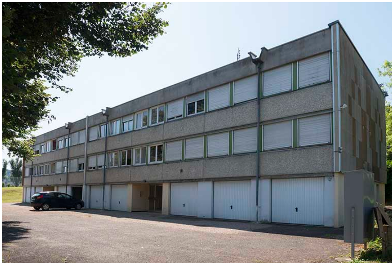
Angle nord-ouest des logements.
