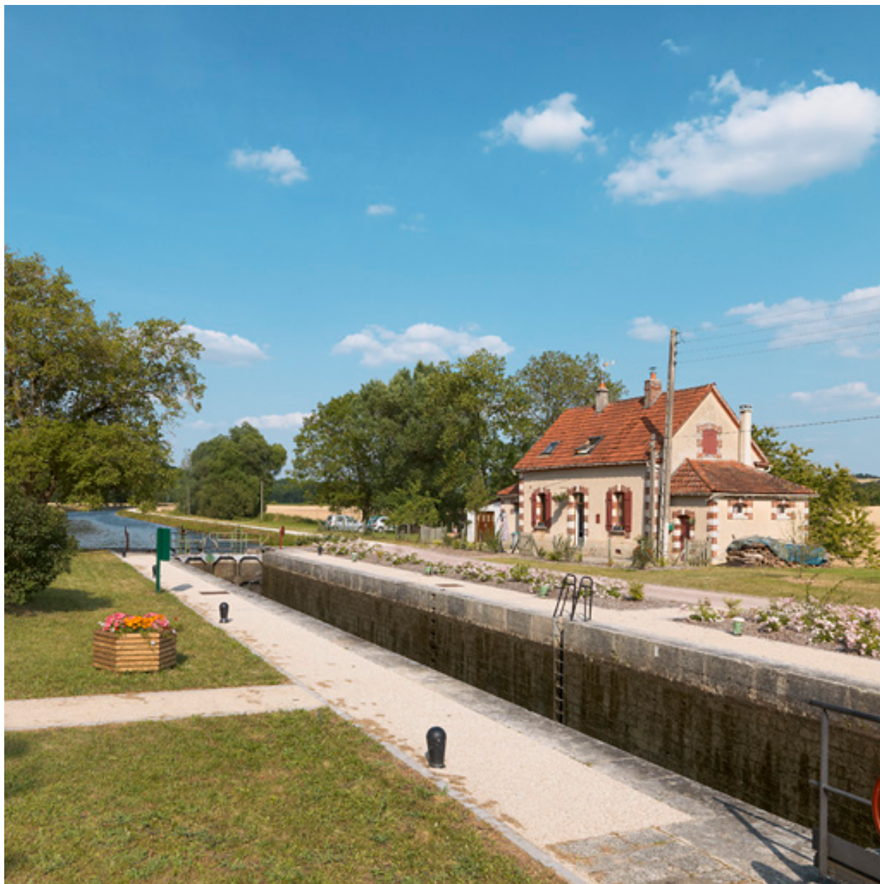
Vue d'aval du site d'écluse.
