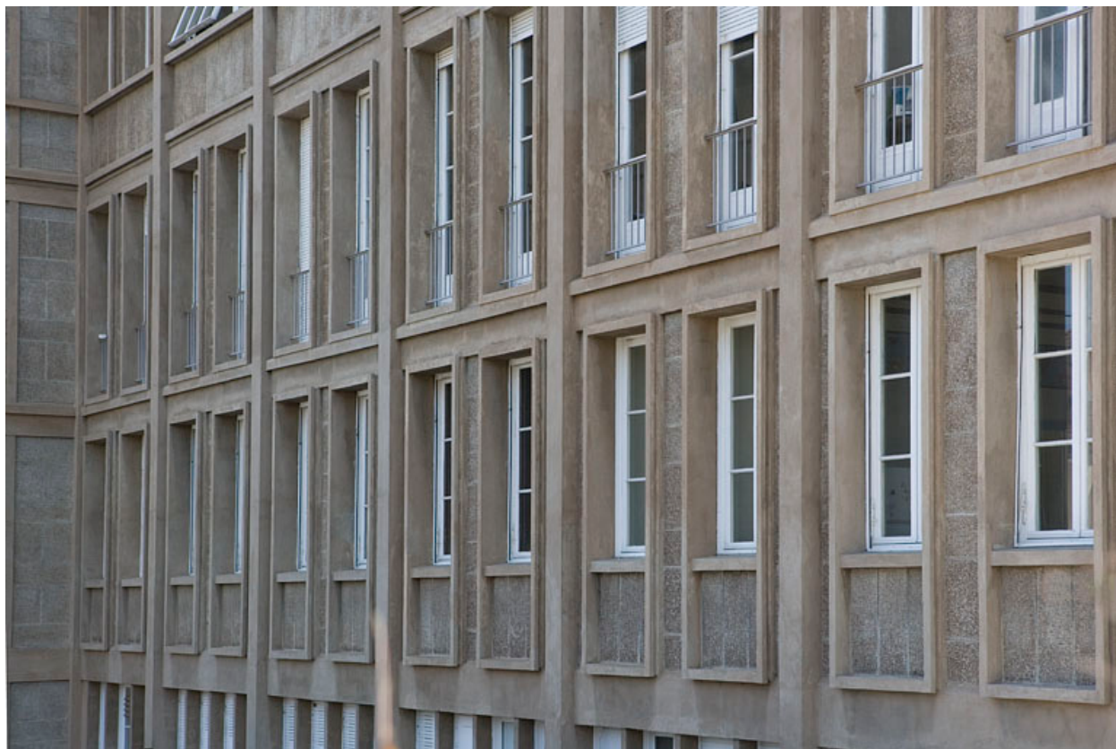
Face latérale droite : fenêtres vues en enfilade.
