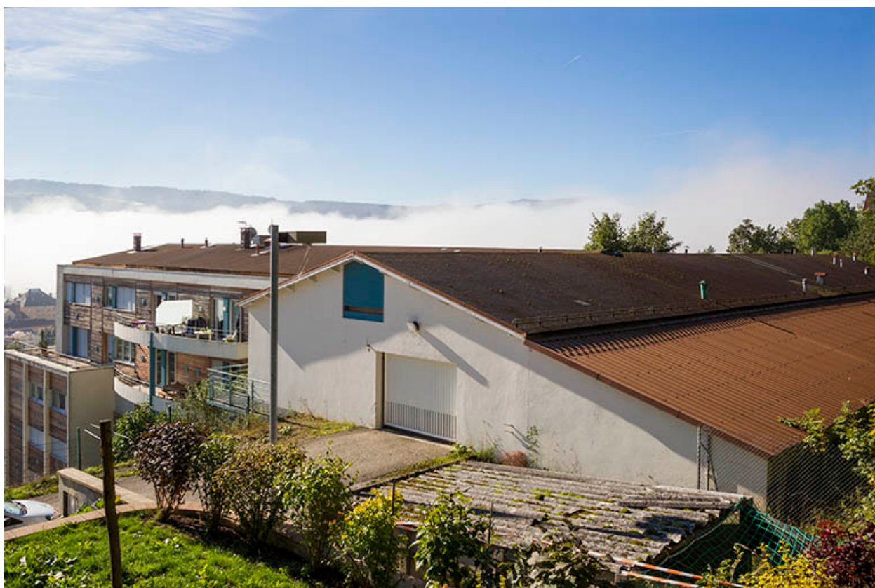
Façade latérale droite, de trois quarts droite.
