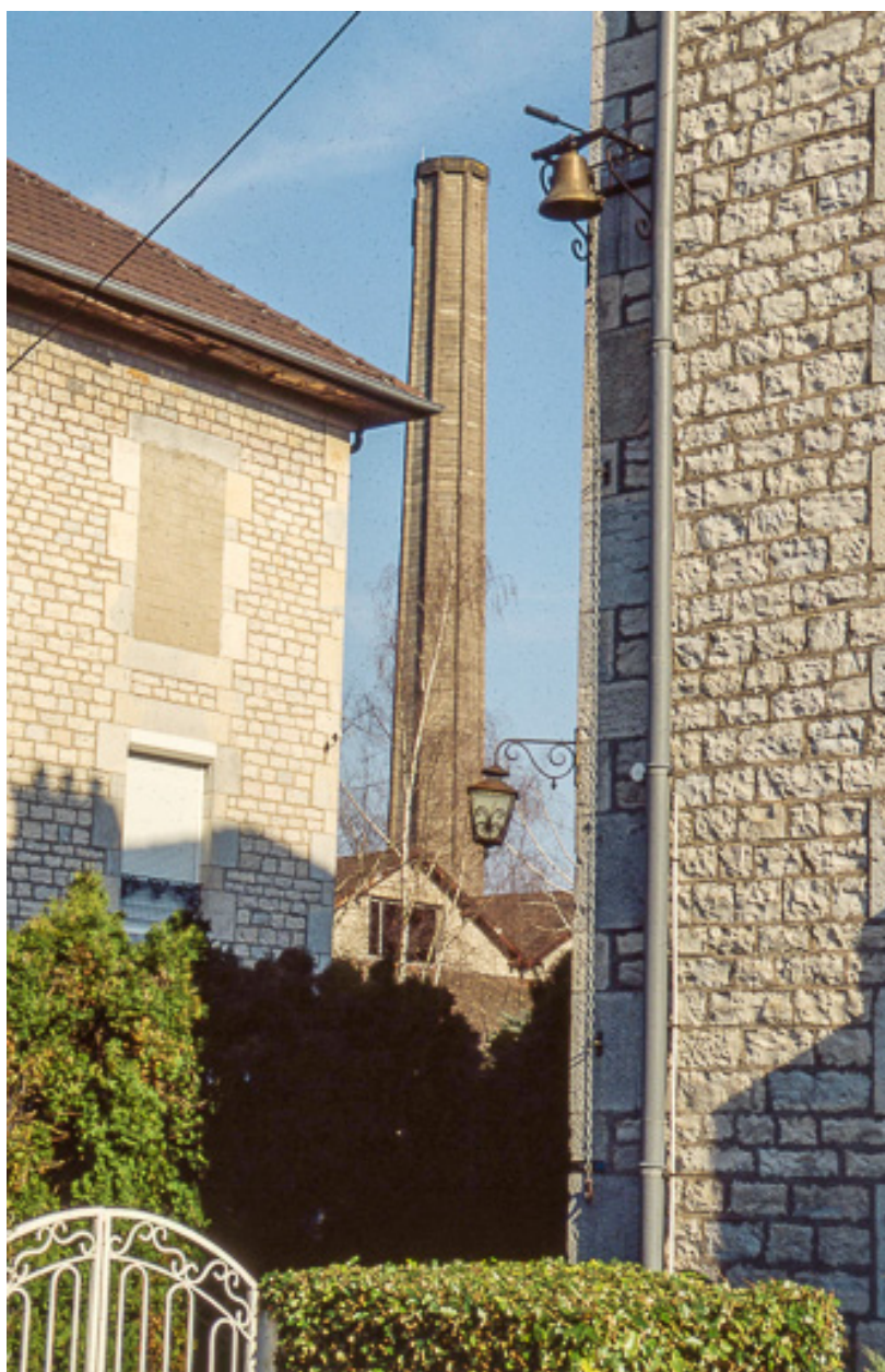
Bureaux, logements et cheminée.
