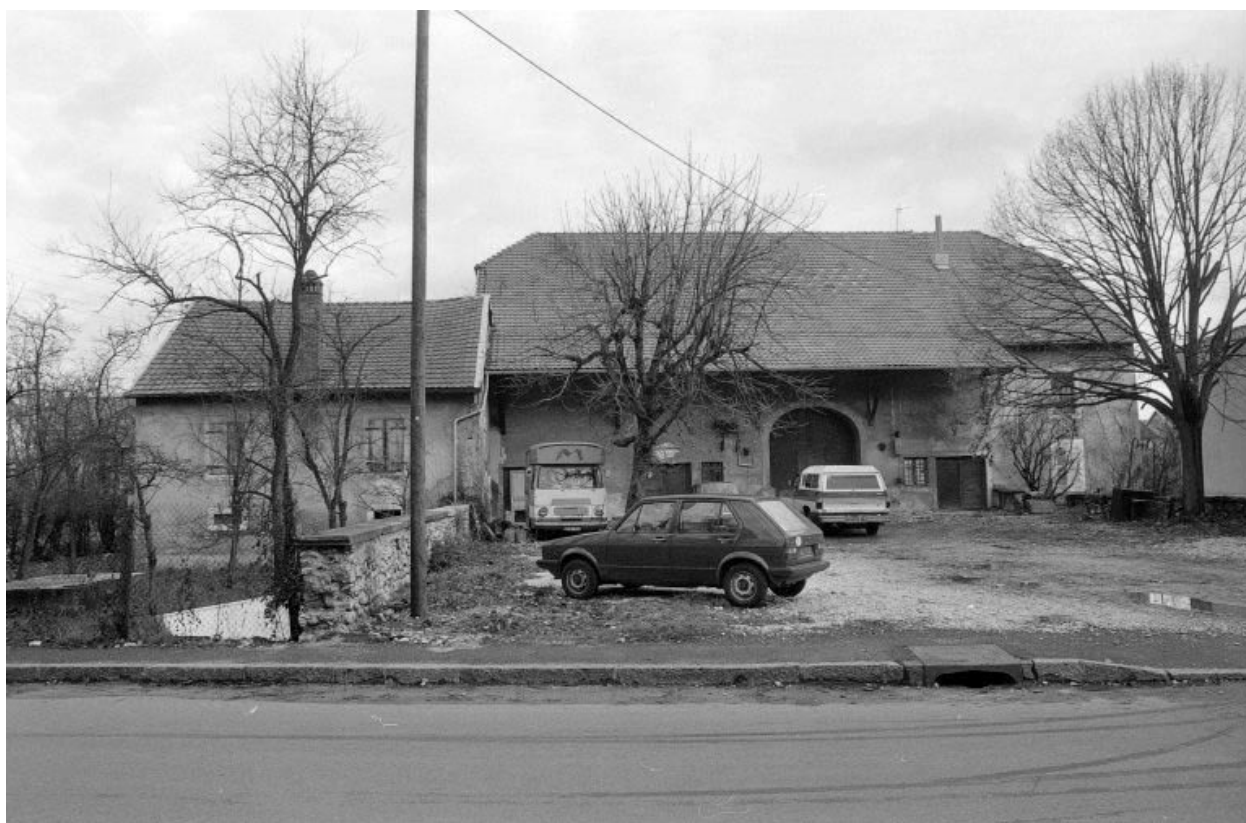
Audincourt : ferme située 9 rue de Valentigney.
