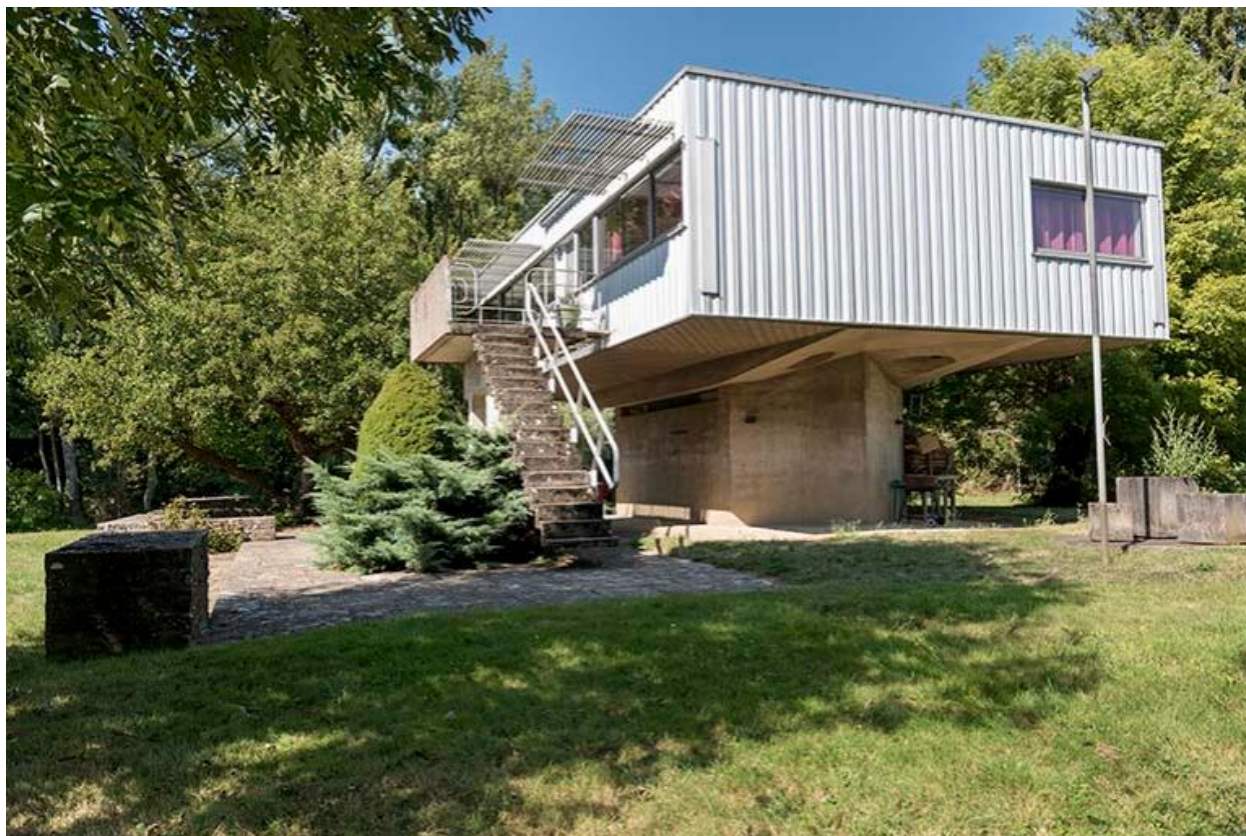
Villa, angle sud-ouest
