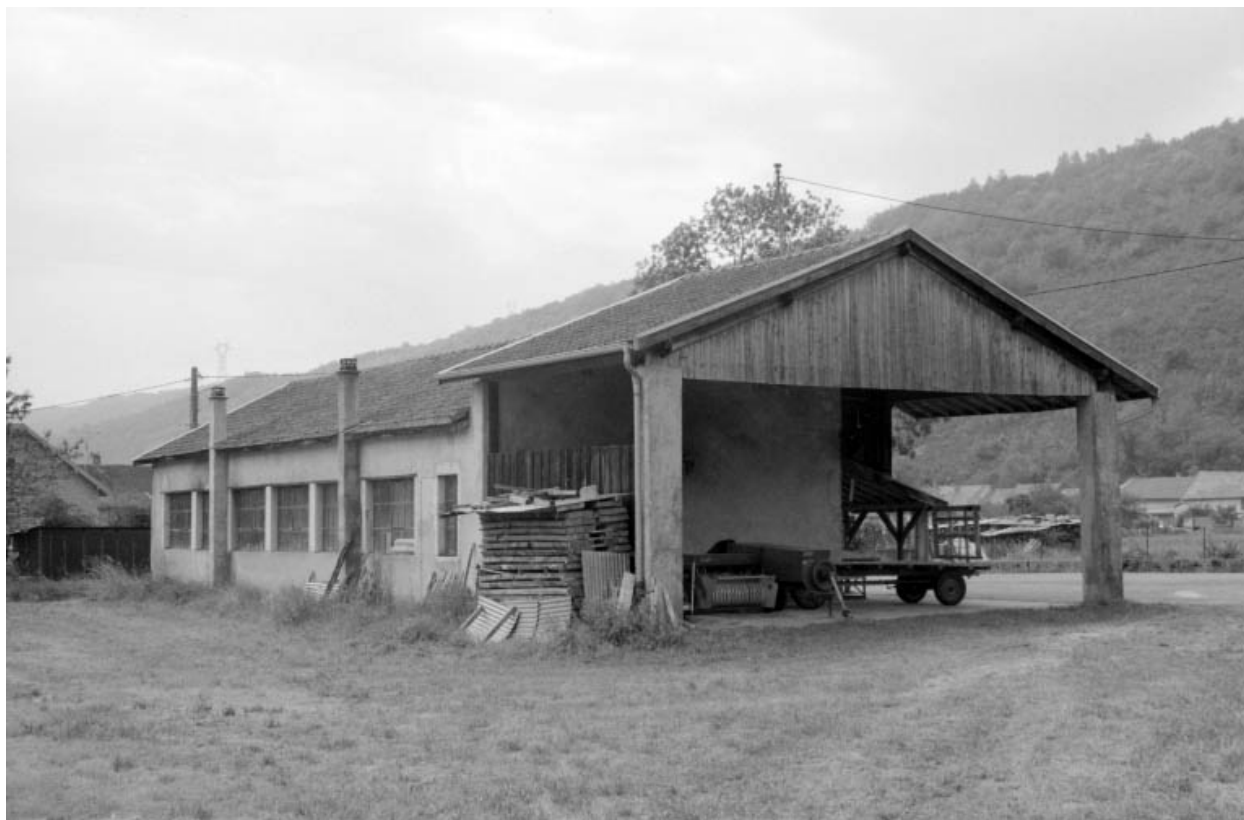
Façades postérieure et latérale gauche.
