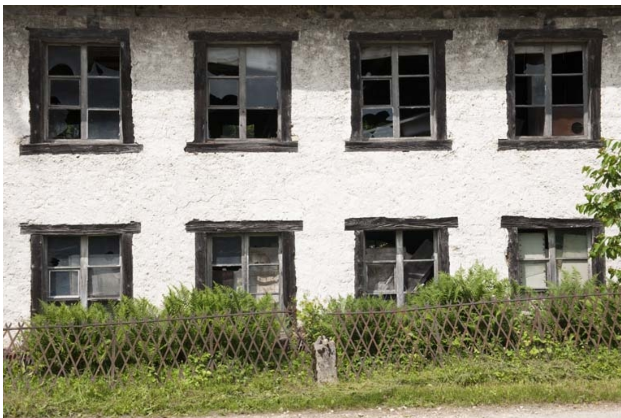
Détail de la façade est de l'atelier.
