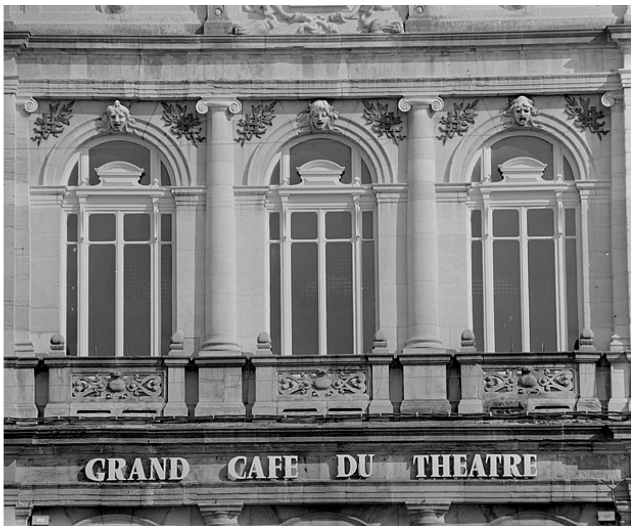
Façade antérieure, baies de l'étage.
