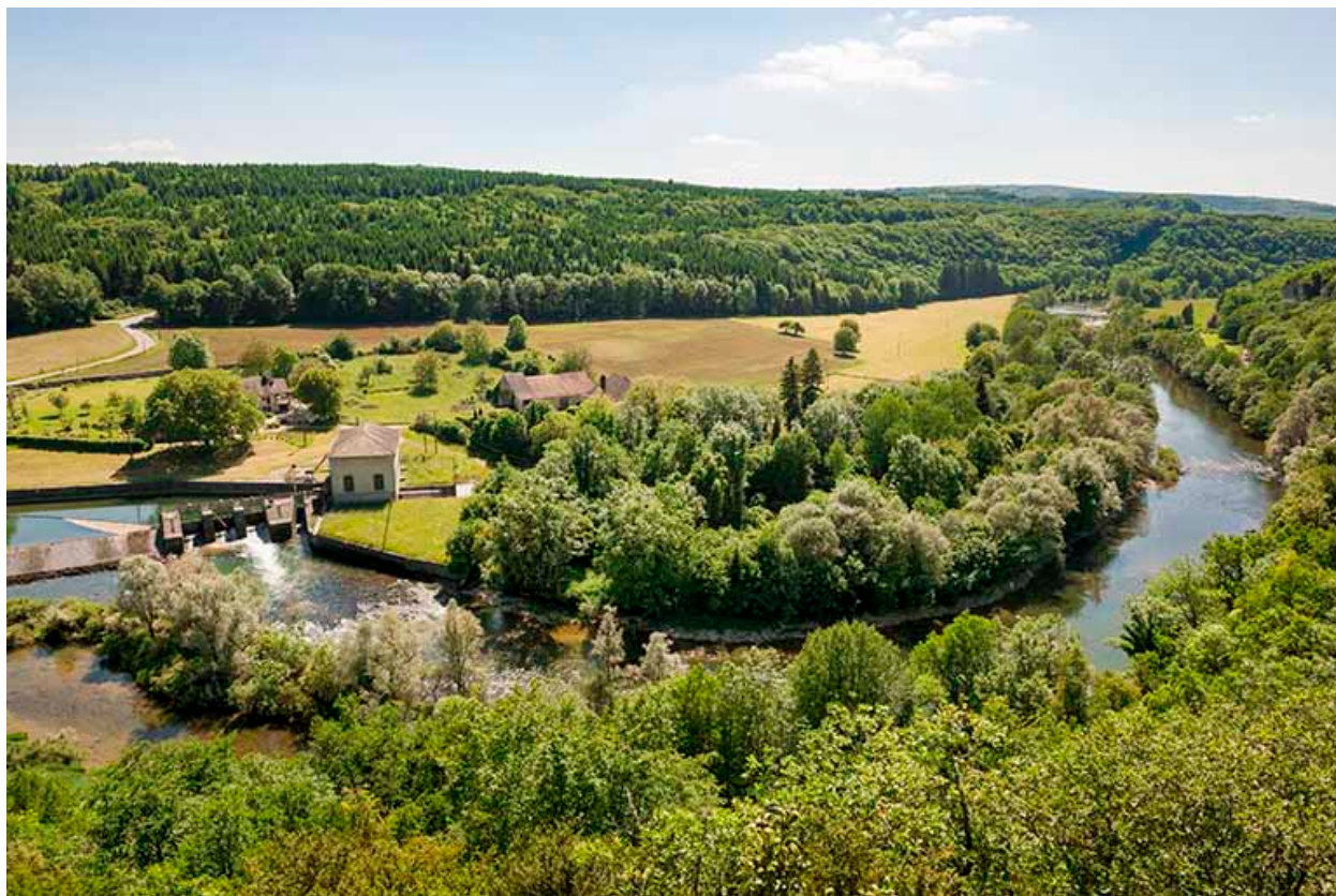
Forges de Châtilion-sur-Lison puis centrale hydroélectrique, Châtilion-sur-Lison.
