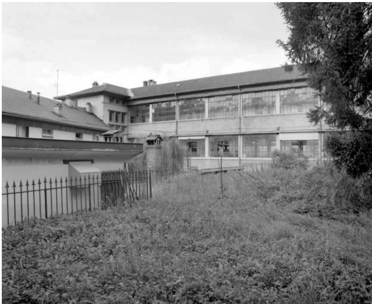
Façade latérale droite du 1er bâtiment.
