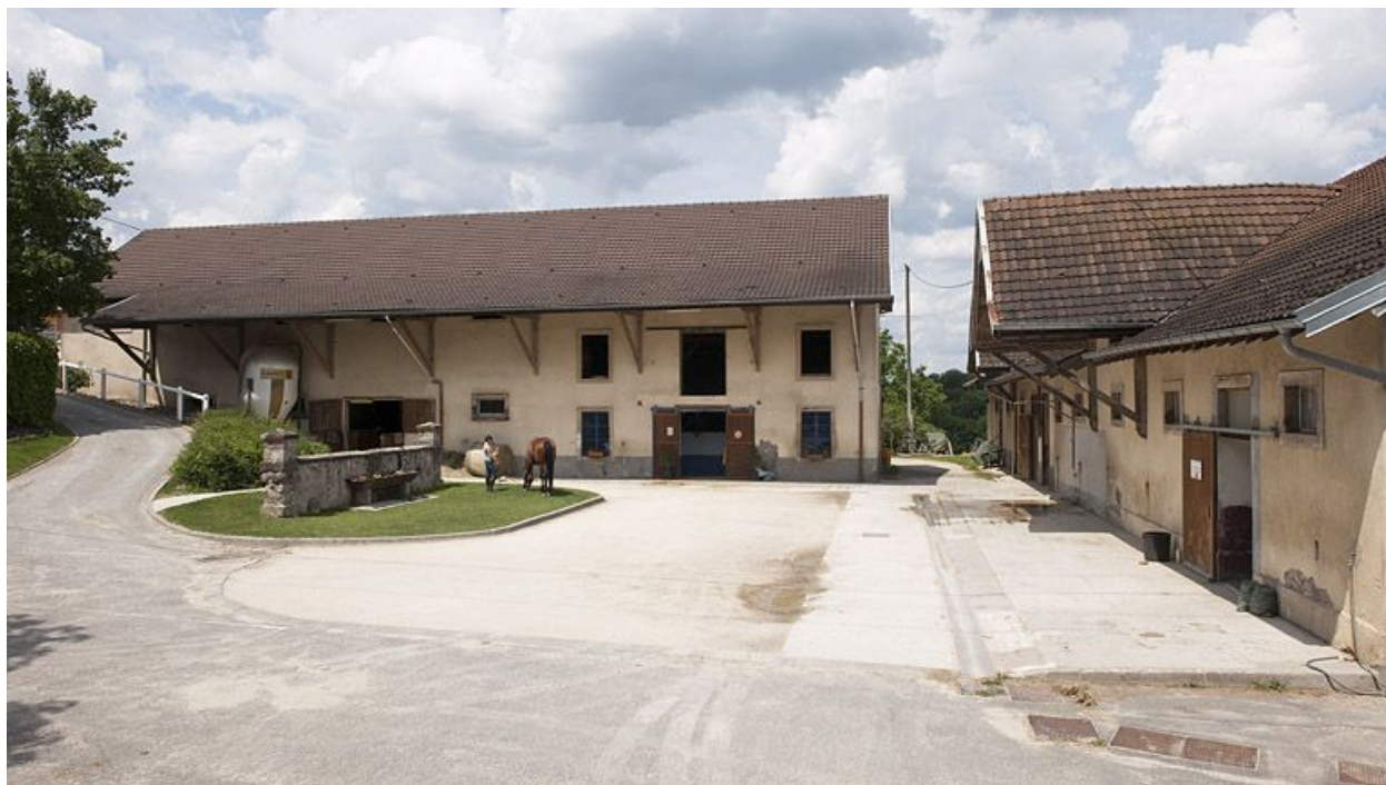
Cour de la ferme et bâtiments agricoles.
